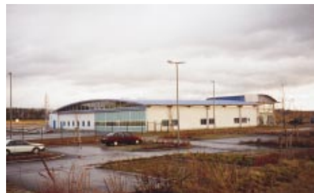
De nieuwe hangar met kantoorruimte van Lange Flugzeugbau
